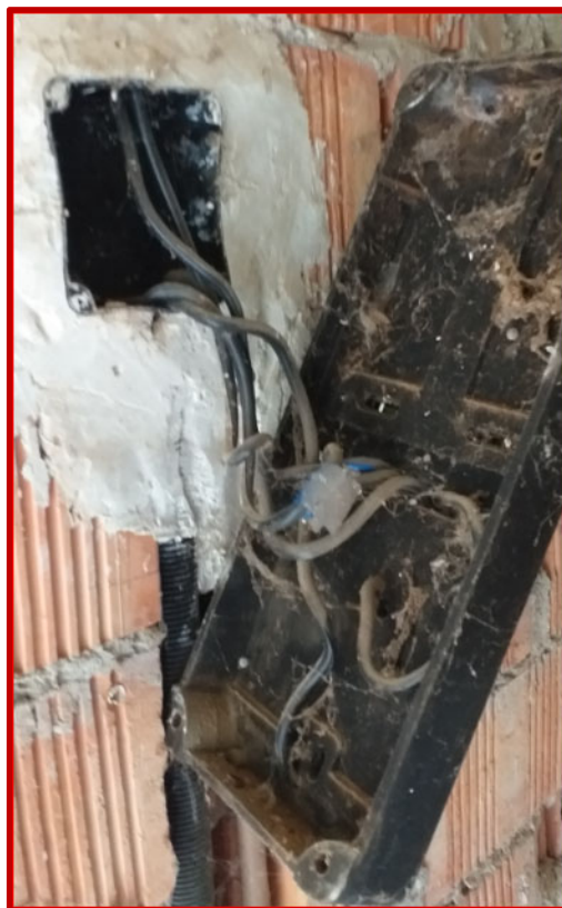
Ismeretlen eredetű, megviselt állapotú sorkapocs – cserélendő :
