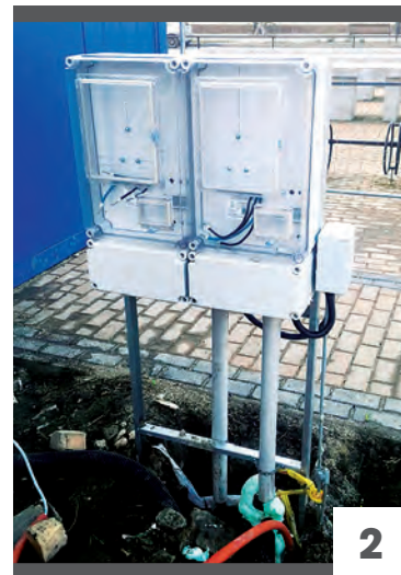
2. kép: Regisztrált villanyszerelő által kialakított fogyasztásmérőhely.
