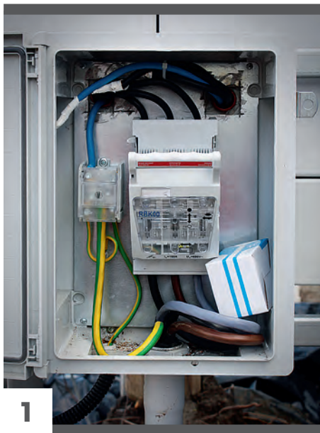
2. kép: Regisztrált villanyszerelő által kialakított fogyasztásmérőhely.
